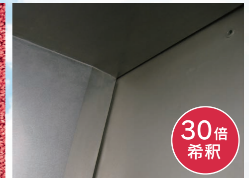
内壁面・パーテーション
