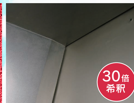
内壁面・パーテーション
